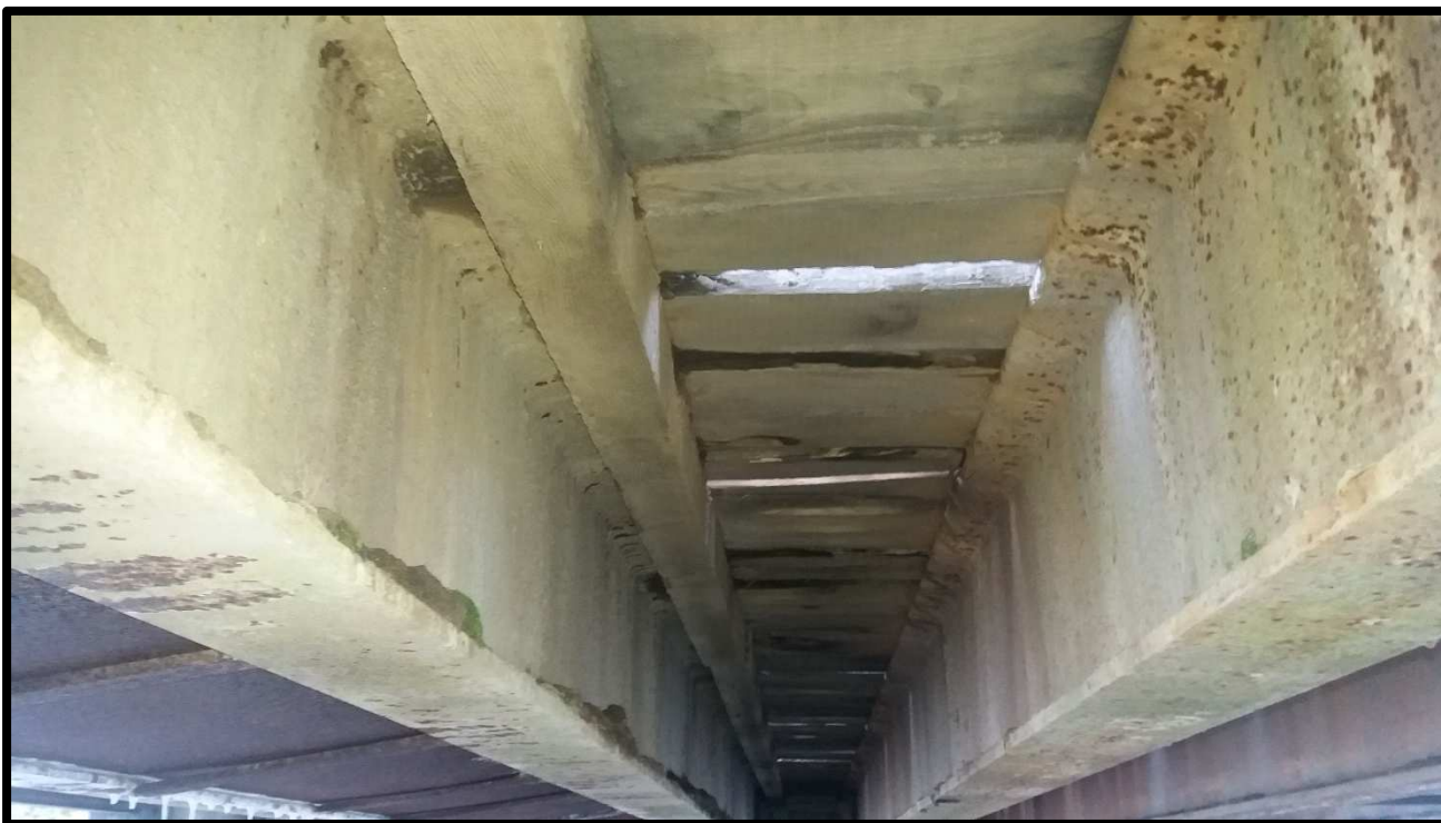
Foto 5 – Struttura portante in acciaio del ponte
