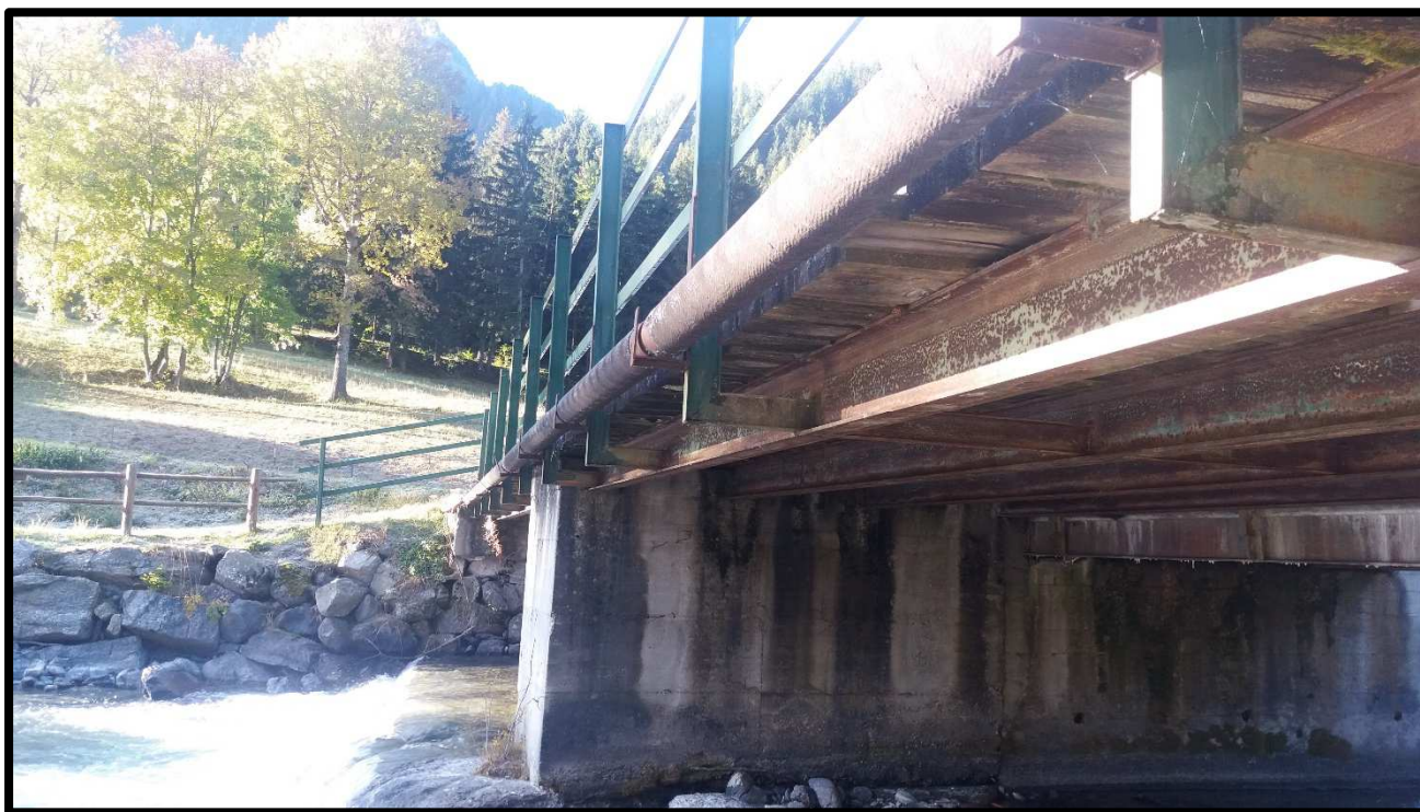
Foto 8 – Sotto-servizi ancorati al ponte lato pista da fondo
